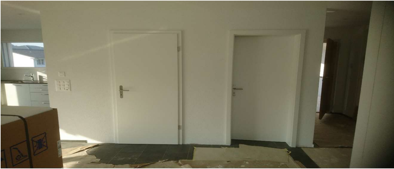
Zimmertüren und Eingangstüren
